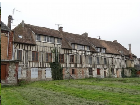
L'usage de pans de bois et de tuiles plates
