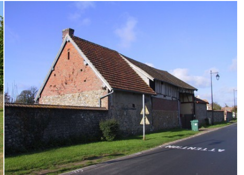
Moellons, briques et pans de bois
