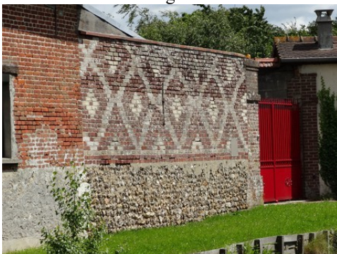
Un mur en moellons et briques
